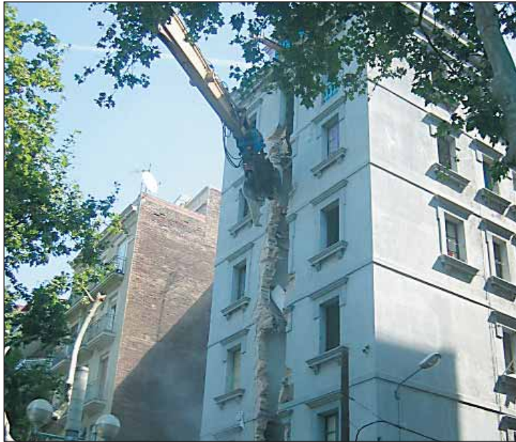
Operación de derribo de Miles de Viviendas.
